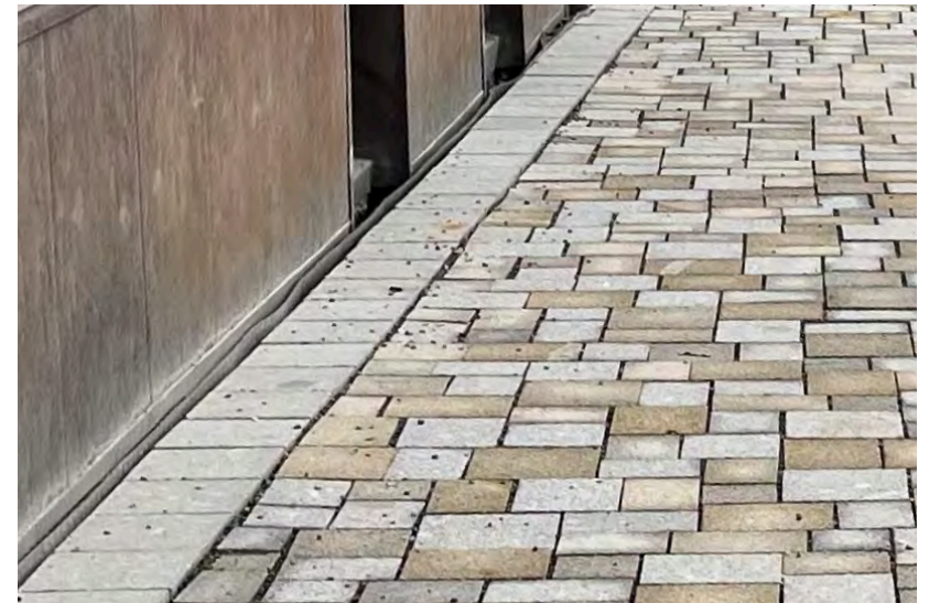
Regeldetail F01 Fassadenanschluss Gehweg - Privat Gebäude
